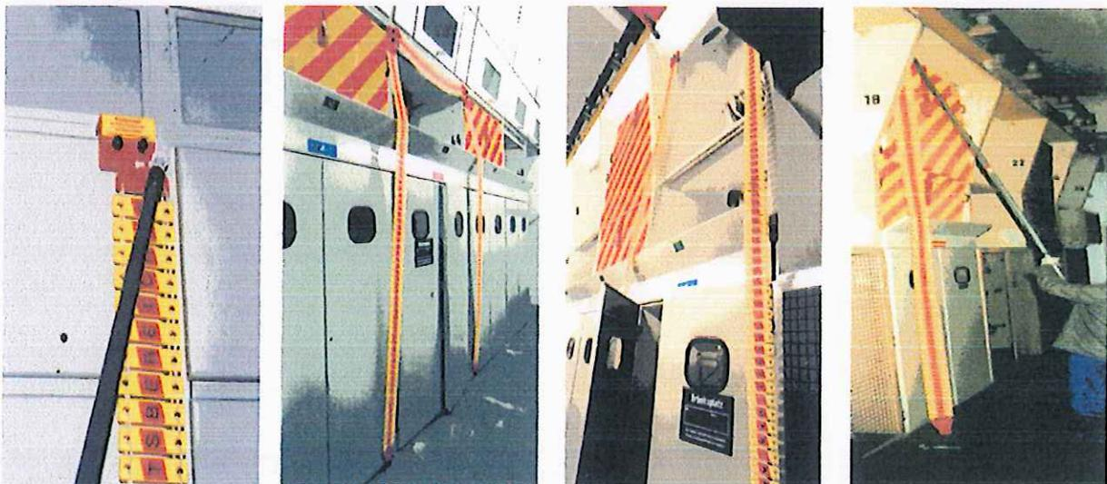
Absperrungen, Kennzeichnungen und die Sicherung von Arbeitsstellen in Schaltanlagen erfolgen mit **Magnetschuhen** im Hinblick auf Arbeitssicherheit als optimale Maßnahme nach BGV A1; BGV A3 und DIN VDE 0105 Teil 100. Fordern Sie unsere spezifischen Unterlagen und Prüfberichte an.
