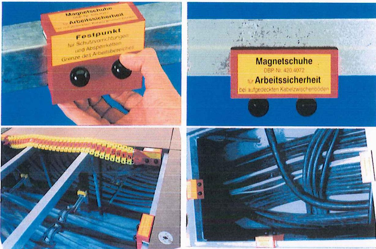
Die Sicherung von Abdeckplatten bei Arbeitsstellen in Kabelzwischenböden ist zwingend notwendig.
